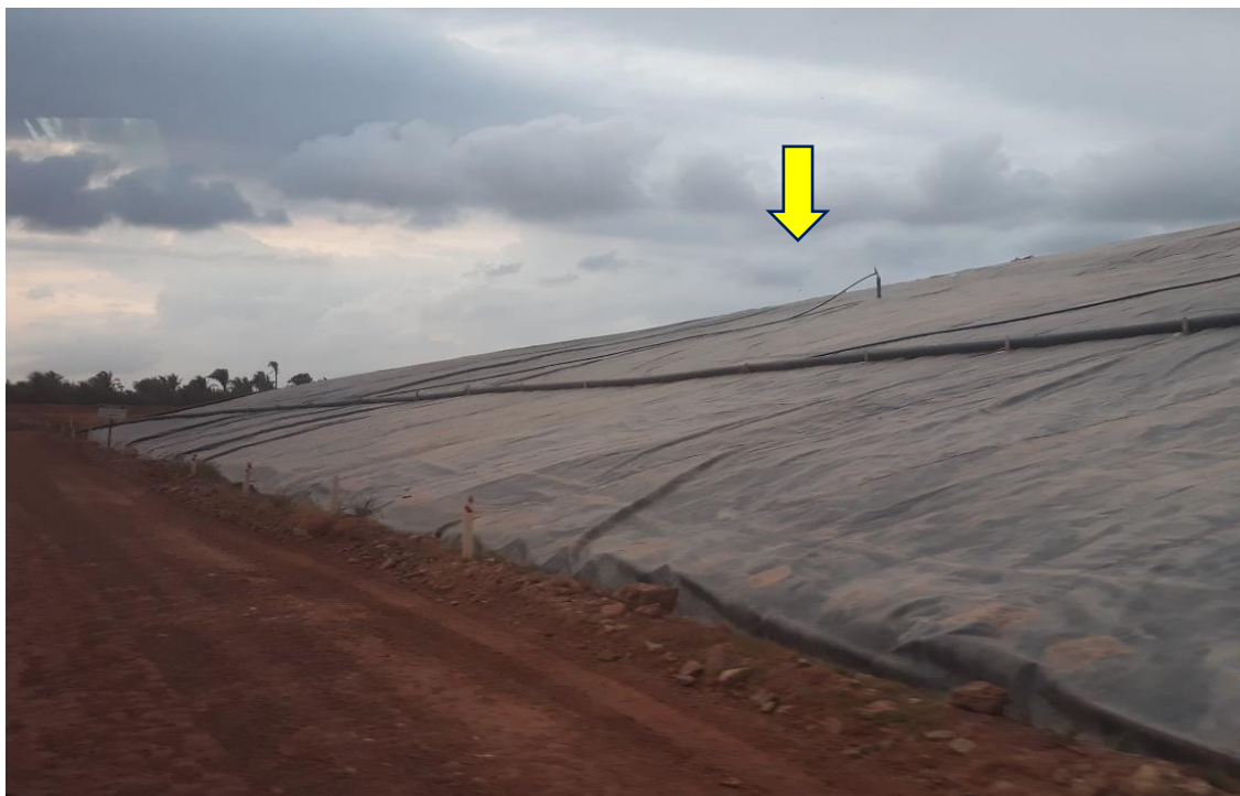
Figura 18 - Na seta amarela na imagem, detalhe do sistema de captação do biogás Fonte: Ibict (2019)
