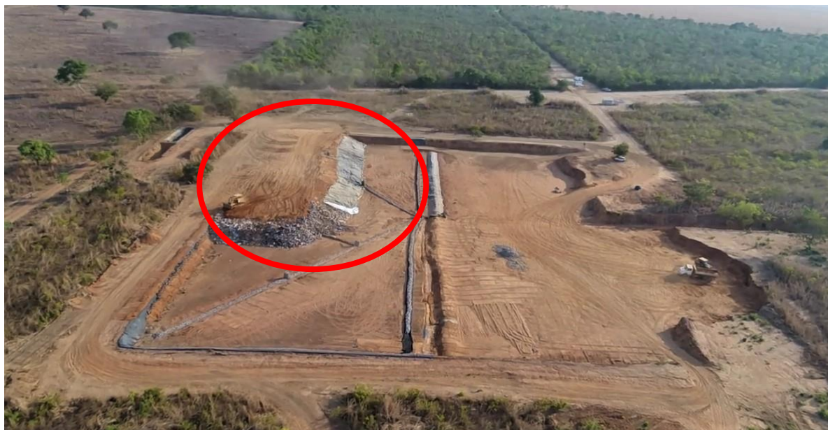
Figura 22 - Na elipse em vermelho, destaque para os resíduos atualmente aterrados Fonte: Alves (2019)
