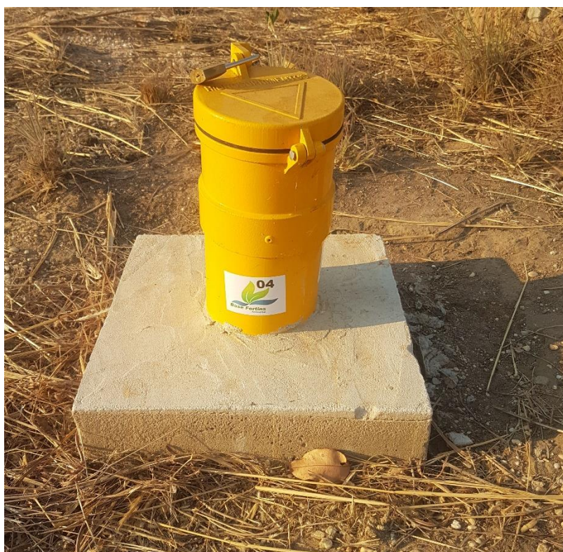
Figura 23 - Poço de monitoramento da água Fonte: Ibict (2019)
