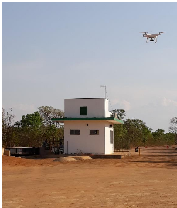
Figura 20 - Guarita onde são recepcionados e pesados os caminhões Fonte: Ibict (2019)
