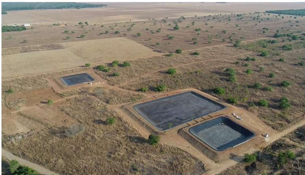
Figura 24 - Vista aérea das 3 lagoas de contenção do aterro sanitário ainda vazias Fonte: Alves (2019)
