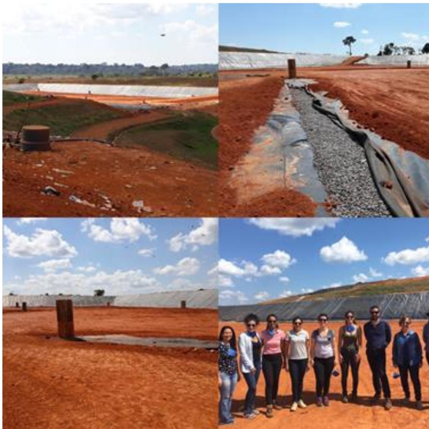
**Figura 27 - Célula nova já devidamente impermeabilizada pela manta de polietileno**
